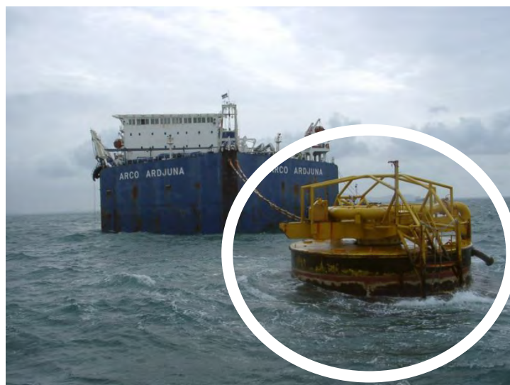
Gambar 4.124 Foto struktur Single Point Mooring
