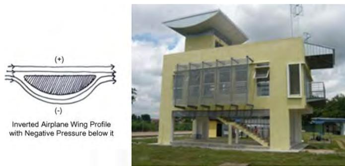
Gambar 2.62 Percobaan menggunakan *Airplan Wing Profile* (Saadatian dkk, 2011)
