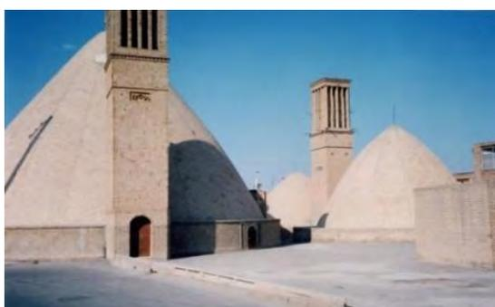
Gambar 2.28 Ab anbar dengan kubah ganda dan *windcatcher* di kota gurun pusat Naeen, dekat Yazd, Iran (Wikipedia, 2014)
