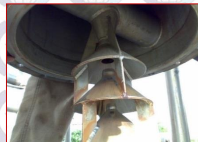
Gambar 4.13. Pengecekan Kondensor Unit
