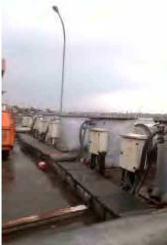
Gambar 2.11 Pompa Submersible dan Pompa Lumpur Rumah Pompa Greges Sumber: Hasil Observasi Lapangan, 2016
