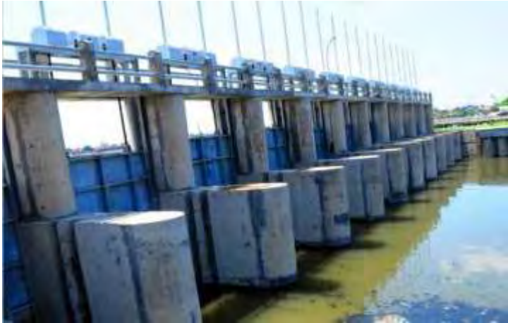
Gambar 2.10 Pintu Air Rumah Pompa Greges Sumber: Hasil Observasi Lapangan, 2016
