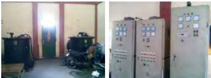
Gambar 2.14 Pompa Submersible dan Pompa Lumpur Rumah Pompa Dupak Bandarejo
