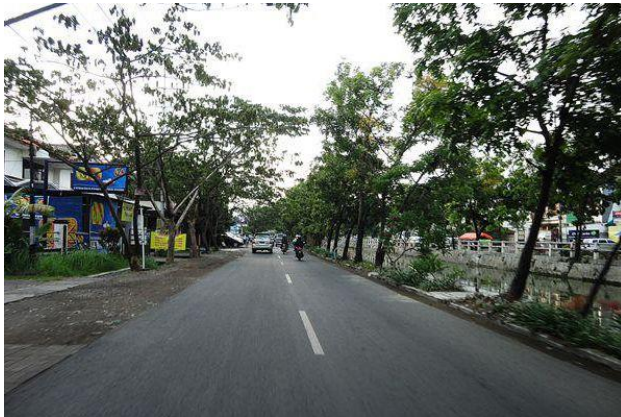
Gambar 3.11 Kondisi jalan untuk pengujian percepatan kendaraan
