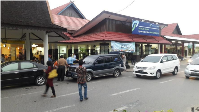
Gambar 3. 2 Situasi Curbside Keberangkatan Terminal Bandar Udara Syamsudin Noor
