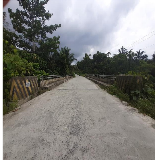
Nama Jembatan : Masei Jenis Jembatan : Girder Bentang : 25 meter Lokasi : Ruas Sarmi-Sentani
