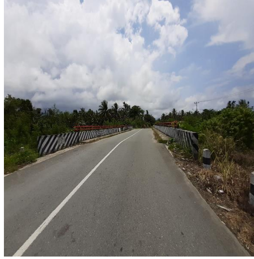
Nama Jembatan : S Rempang Jenis Jembatan : Girder Bentang : 30 meter Lokasi : Ruas Nimbokarang-Sentani
