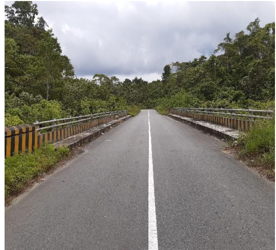
Nama Jembatan : Tibual Jenis Jembatan : Girder Bentang : 25 meter Lokasi : Ruas Sarmi-Sentani
