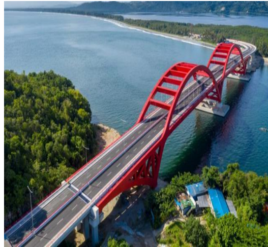
Nama Jembatan : Holtemkamp Jenis Jembatan : Pelengkung Baja Bentang : 400 meter Lokasi : Ruas Jayapura-Muaratami
