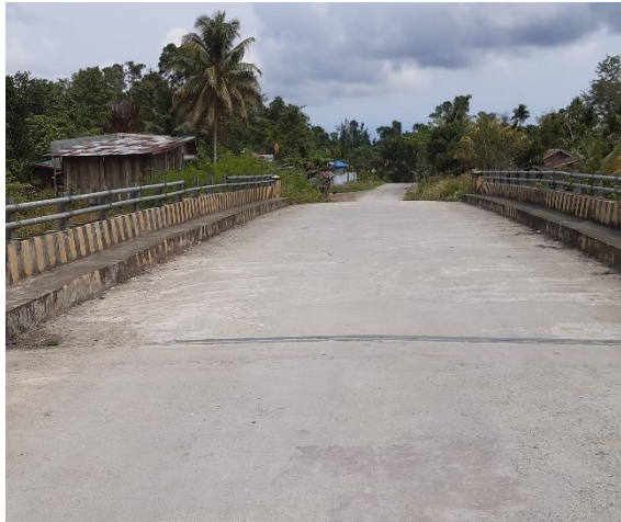
Nama Jembatan : Sayore Jenis Jembatan : Girder Bentang : 25 meter Lokasi : Ruas Sarmi-Sentani
