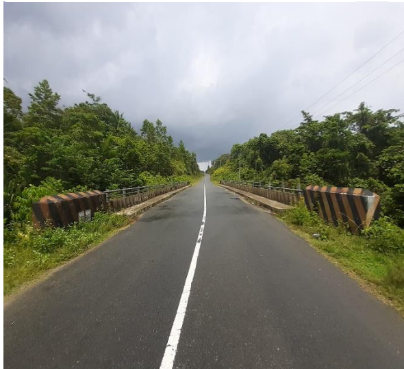
Nama Jembatan : Kali Sum Jenis Jembatan : Girder Bentang : 25 meter Lokasi : Ruas Sarmi-Sentani
