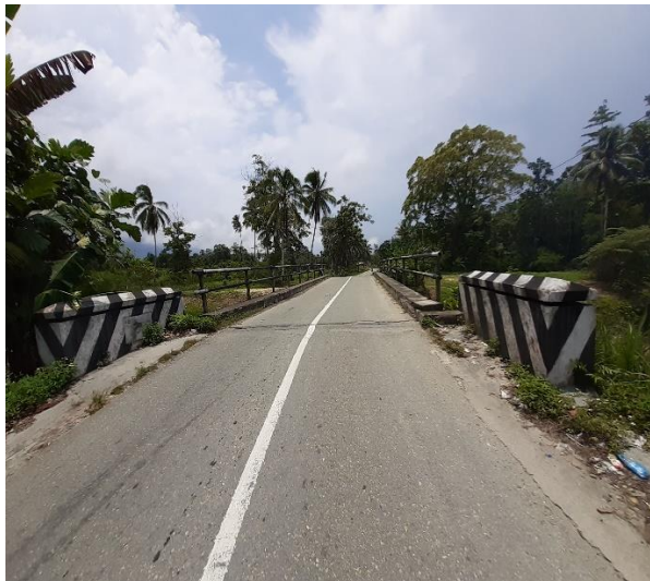
Nama Jembatan : Nimbokrang Jenis Jembatan : Girder Bentang : 15 meter Lokasi : Ruas Nimbokrang-Sentani
