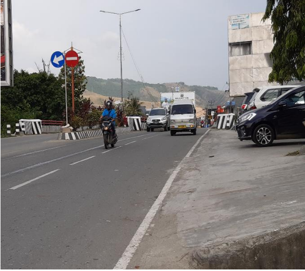
Nama Jembatan : Sentani I Jenis Jembatan : Girder Bentang : 20 meter Lokasi : Ruas Sentani-Jayapura
