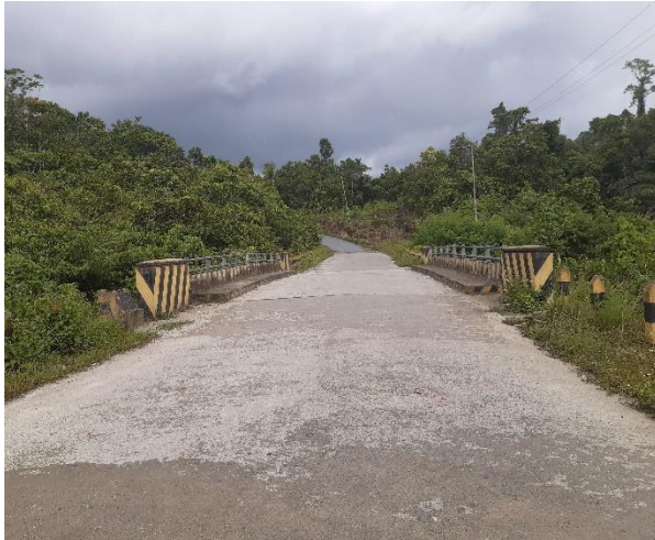
Nama Jembatan : Timbi Jenis Jembatan : Girder Bentang : 15 meter Lokasi : Ruas Sarmi-Sentani
