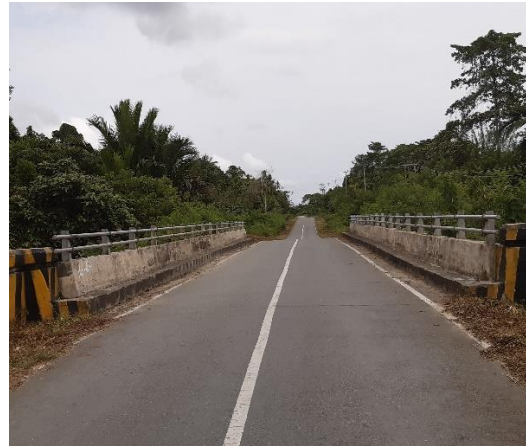
Nama Jembatan : Sosiri I Jenis Jembatan : Girder Bentang : 25 meter Lokasi : Ruas Sarmi-Sentani
