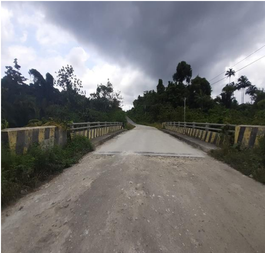
Nama Jembatan : Sanggre Jenis Jembatan : Girder Bentang : 15 meter Lokasi : Ruas Nimbokrang-Sentani
