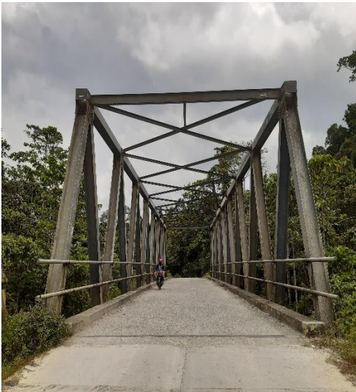
Nama Jembatan : Muaif II Jenis Jembatan : Rangka Baja Bentang : 25 meter Lokasi : Ruas Nimbokrang-Sentani
