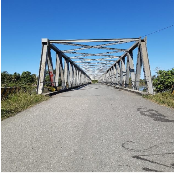
Nama Jembatan : Bier Jenis Jembatan : Rangka Baja Bentang : 100 meter Lokasi : Ruas Sarmi-Sentani
