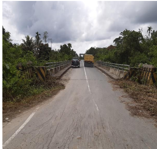
Nama Jembatan : Sosiri III Jenis Jembatan : Girder Bentang : 25 meter Lokasi : Ruas Sarmi-Sentani
