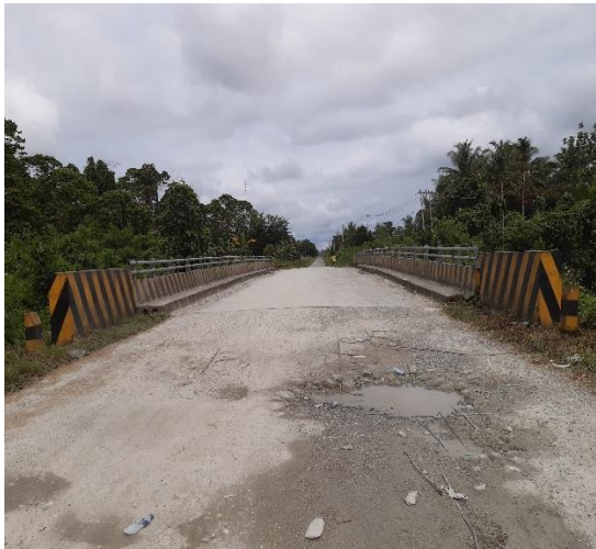
Nama Jembatan : Sosiri IV Jenis Jembatan : Girder Bentang : 30 meter Lokasi : Ruas Sarmi-Sentani
