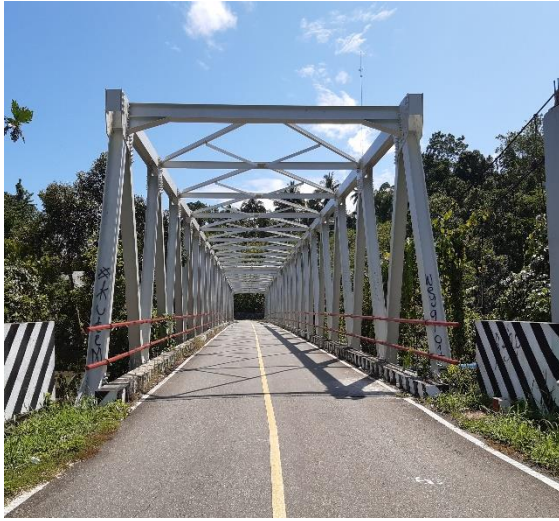
Nama Jembatan : Mosso Jenis Jembatan : Rangka Baja Bentang : 60 meter Lokasi : Ruas Muaratami
