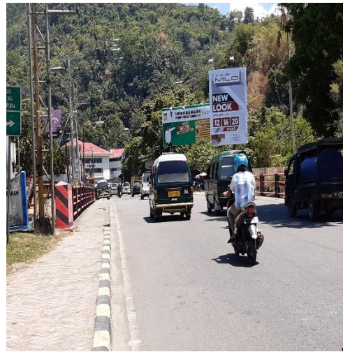
Nama Jembatan : Overtoom Jenis Jembatan : Girder Bentang : 30 meter Lokasi : Ruas Jayapura
