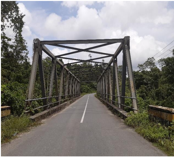
Nama Jembatan : Martare Jenis Jembatan : Rangka Baja Bentang : 25 meter Lokasi : Ruas Sarmi-Sentani
