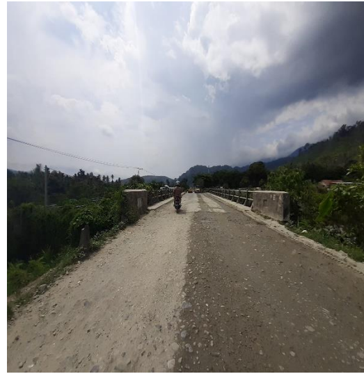
Nama Jembatan : Doyo IV Jenis Jembatan : Girder Bentang : 25 meter Lokasi : Ruas Sentani
