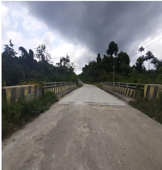
Nama Jembatan : Sangre Jenis Jembatan : Girder Bentang : 15 meter Lokasi : Ruas Sarmi-Sentani
