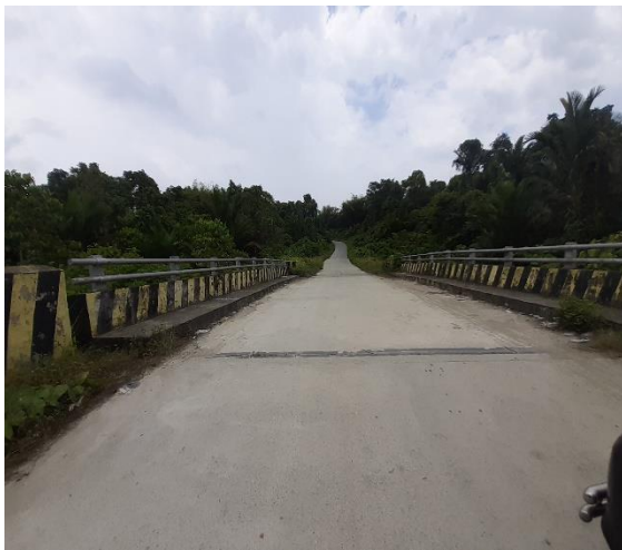
Nama Jembatan : Siul Jenis Jembatan : Girder Bentang : 20 meter Lokasi : Ruas Nimbokrang-Sentani
