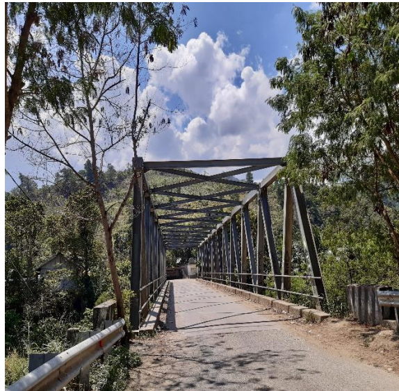
Nama Jembatan : Kojabu Jenis Jembatan : Rangka Baja Bentang : 50 meter Lokasi : Waena
