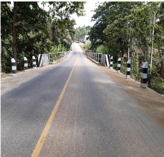
Nama Jembatan : Nafri III Jenis Jembatan : Girder Bentang : 15 meter Lokasi : Ruas Muaratami-Jayapura
