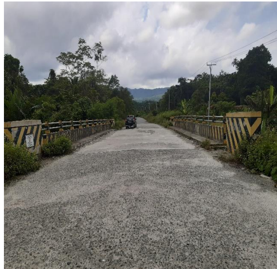
Nama Jembatan : Jinggan Jenis Jembatan : Girder Bentang : 15 meter Lokasi : Ruas Sarmi-Sentani
