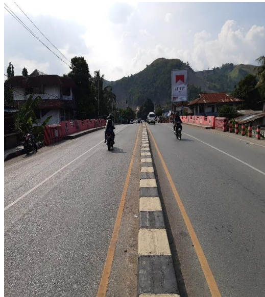
Nama Jembatan : Waena Jenis Jembatan : Girder Bentang : 20 meter Lokasi : Ruas Waena-Jayapura
