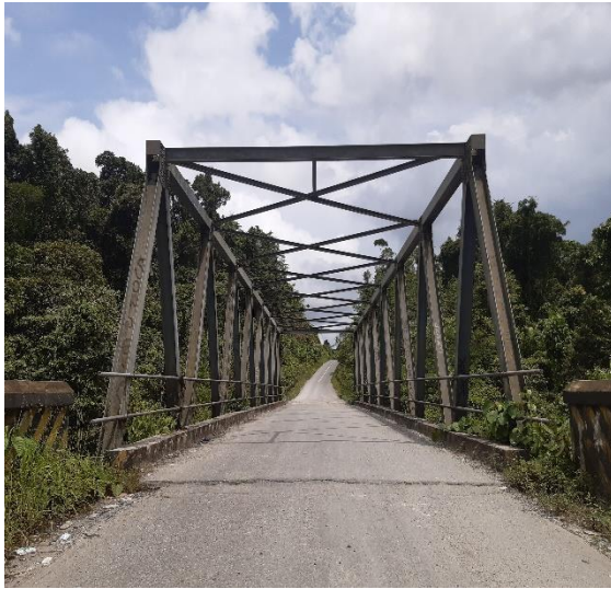
Nama Jembatan : Kali Abu Jenis Jembatan : Rangka Baja Bentang : 25 meter Lokasi : Ruas Sarmi-Sentani
