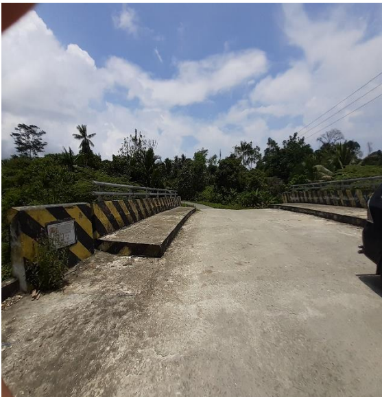
Nama Jembatan : Borrowa Jenis Jembatan : Girder Bentang : 12 meter Lokasi : Ruas Sarmi-Sentani
