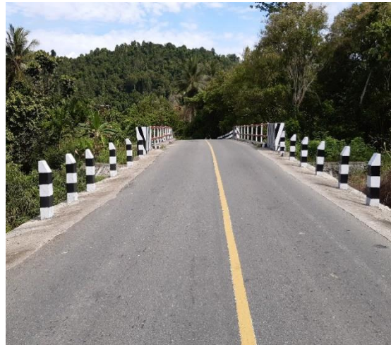
Nama Jembatan : Nafri II Jenis Jembatan : Girder Bentang : 20 meter Lokasi : Ruas Muaratami-Jayapura
