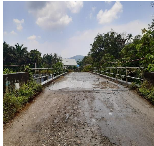
Nama Jembatan : Waibron Jenis Jembatan : Girder Bentang : 25 meter Lokasi : Ruas Kertosari-Sentani
