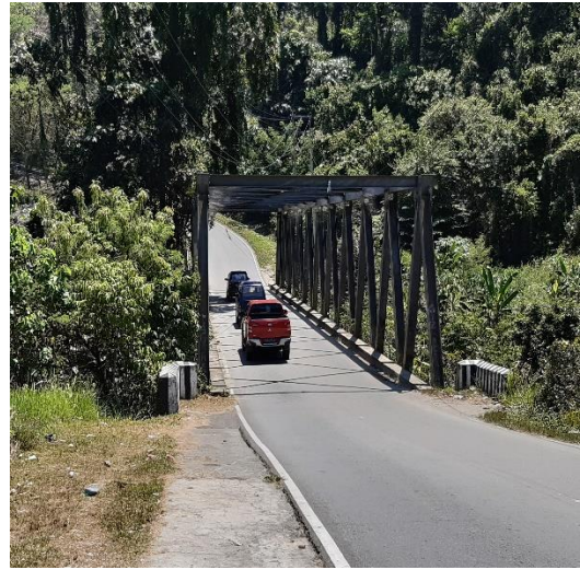
Nama Jembatan : Anafre Jenis Jembatan : Rangka Baja Bentang : 25 meter Lokasi : Ruas Waena-Entrop
