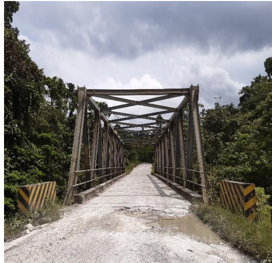
Nama Jembatan : Muaif V Jenis Jembatan : Rangka Baja Bentang : 20 meter Lokasi : Ruas Nimbokrang-Sentani
