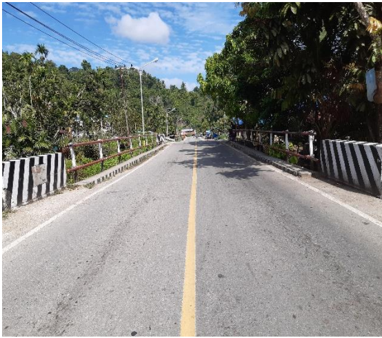
Nama Jembatan : Nafri I Jenis Jembatan : Girder Bentang : 20 meter Lokasi : Ruas Muaratami-Jayapura
