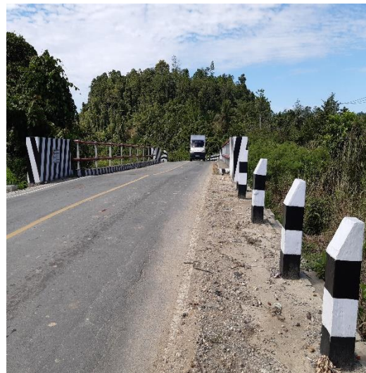
Nama Jembatan : Nafri IV Jenis Jembatan : Girder Bentang : 15 meter Lokasi : Ruas Muaratami-Jayapura
