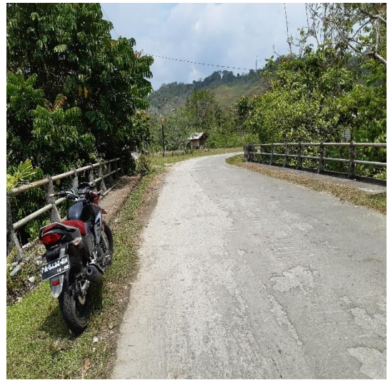
Nama Jembatan : Pintu Air II Jenis Jembatan : Girder Bentang : 10 meter Lokasi : Ruas Kertosari-Sentani
