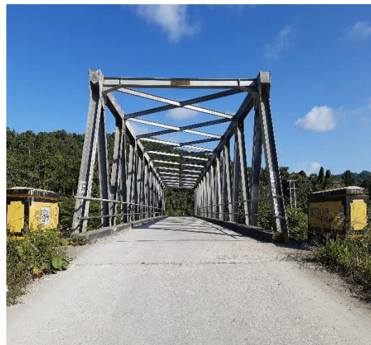
Nama Jembatan : Kali Waskey Jenis Jembatan : Rangka Baja Bentang : 60 meter Lokasi : Ruas Sarmi-Sentani
