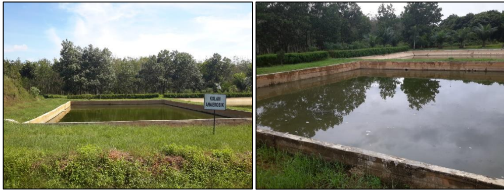
Gambar 4.14. Kolam Anaerobik
