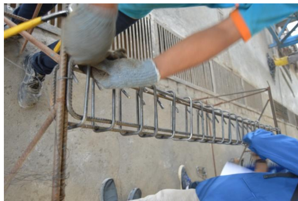
Foto Perakitan Tulangan Beton
