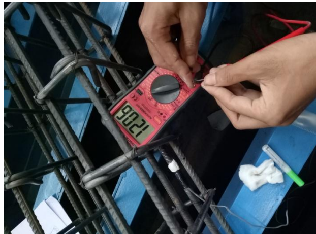
Foto Pemasangan dan Pengecekan Strain Gauge Pada Tulangan
