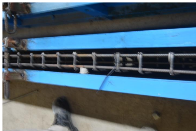
Foto Peletakkan Tulangan dalam Beton dengan Tambahan Tahu Beton
