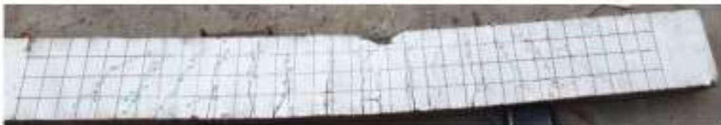
Gambar Balok SMFA setelah pengujian four point bending
