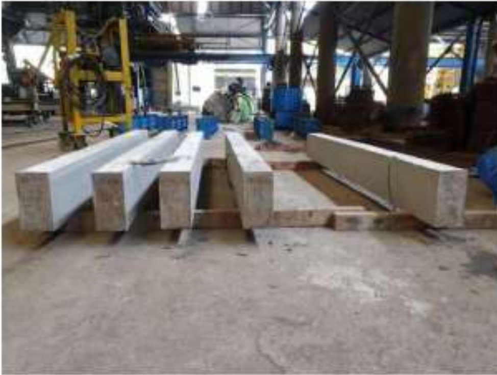
Gambar Balok setelah dikeluarkan dari cetakan
