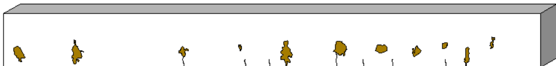
Gambar4.20 Balok ECC korosi minggu kedua
