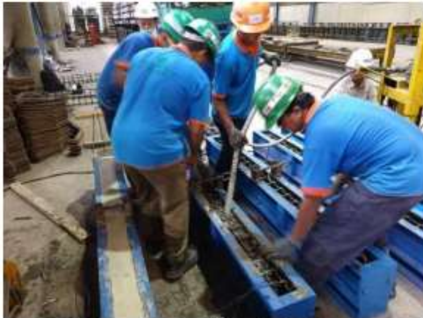
Gambar Pengecoran Balok NC dan balok SMFA
