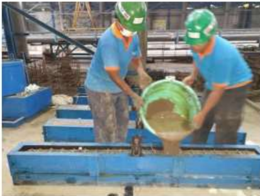
Gambar Pengecoran Balok ECC
