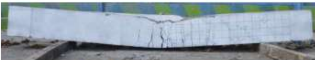
Gambar Balok Beton SMFA setelah Pengujian Four Point Bending
