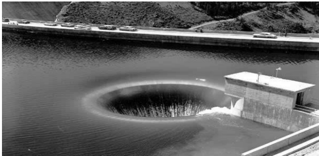
Gambar 2. 12 Spillway Saluran Morning Glory (Sumber: google.com)
