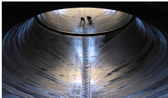
Gambar 2. 11 Spillway Saluran Terowongan (Sumber: google.com)
