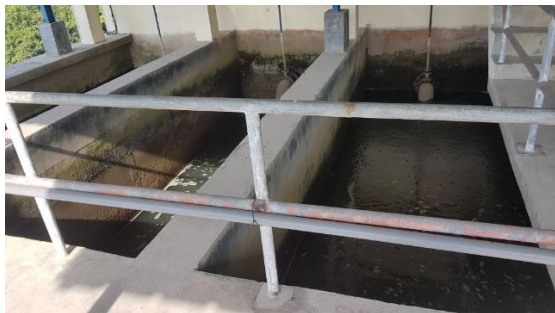
Gambar 2.8 Unit Filtrasi IPA PDAM Kota Mojokerto
