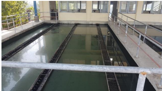
Gambar 2.7 Unit Sedimentasi IPA PDAM Kota Mojokerto
