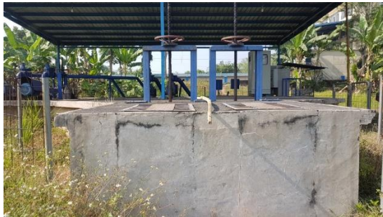
Gambar 2.4 Sumur Pengumpul dan Pompa IPA PDAM Kota Mojokerto
