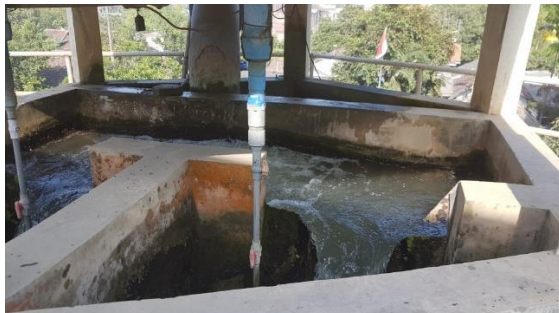
Gambar 2.5 Koagulator (Terjunan) IPA PDAM Kota Mojokerto
