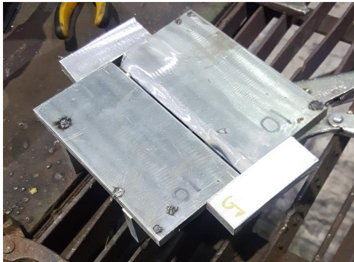
Gambar III.7 Material sudah disusun dan dipasang tanggem
