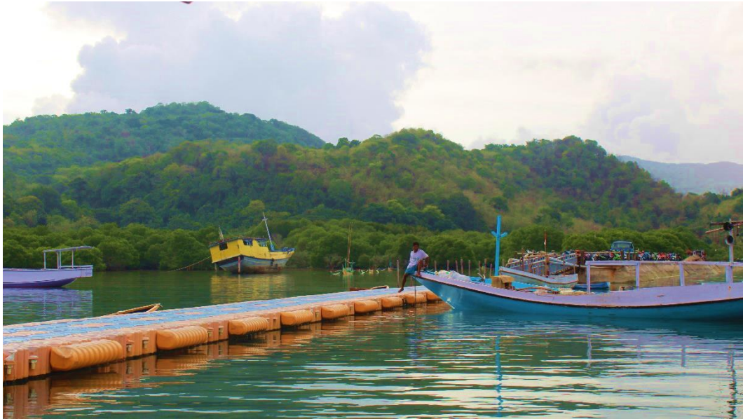
Gambar 4.15 Jembatan Apung Pulau Bawean
