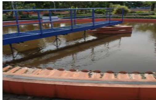
Gambar 3. 6 Kondisi Eksisting Clarifier
