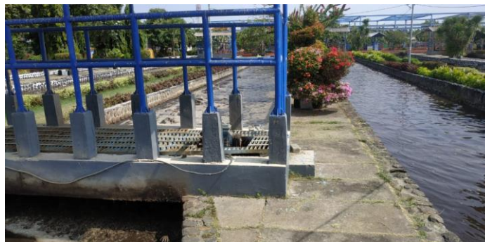
Gambar 3. 5 Kondisi Eksisting Oxidation Ditch
