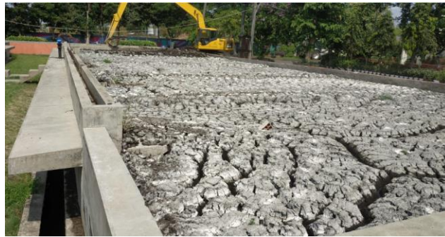
Gambar 3. 7 Kondisi Eksisting Sludge Drying Bed
