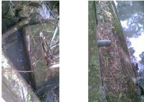
Gambar 5. 6 Kondisi Air Limbah yang Meluber dari Manhole (Kiri) dan Air Hasil Olahan IPAL yang tidak keluar dari IPAL (Kanan)
