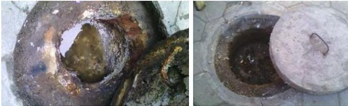
Gambar 5. 4 Kondisi Manhole IPAL Roomo Saat Survei Awal (Kiri) dan Kondisi Manhole IPAL Roomo Saat Terjadi Penyumbatan (Kanan)
