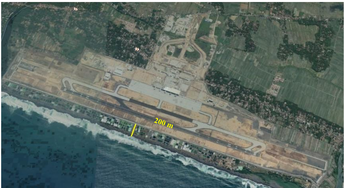
Gambar 1.2 Bandara Internasional Yogyakarta (www.earth.google.com)
