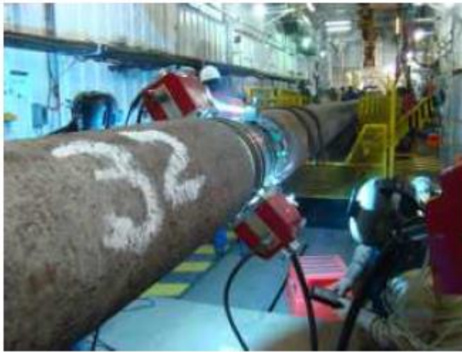
Gambar 2.4 Pengelasan Pipa Bawah Laut (sumber: Drehem, 2016)
