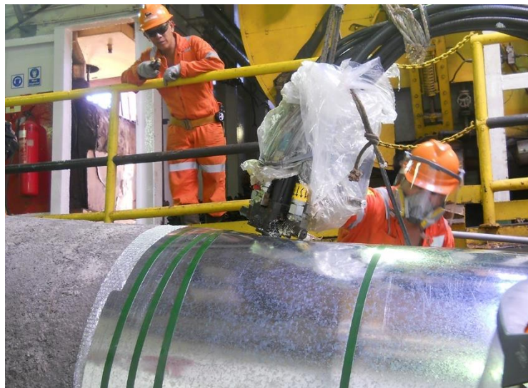
Gambar 2.6 Injeksi HDPU Foam pada Joint Pipa (sumber: Pertamina)
