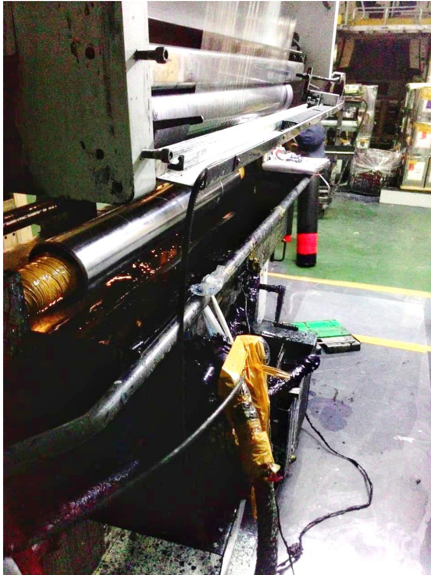
Gambar 5.10 pemasangan kontak kabel agar pegangan pekerja tertanahkan
