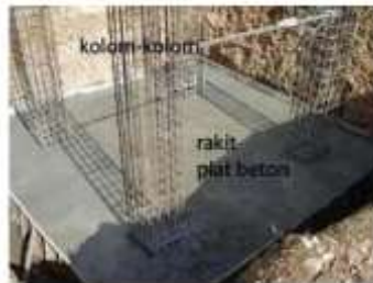
Gambar 2.17 Pondasi Rakit (Sumber : http://docplayer.info/47175339 ) Tanggal Akses : 22 Juni 2019
