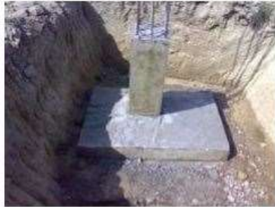
Gambar 2.16 Pondasi Telapak (Sumber : http://docplayer.info/47175339 ) Tanggal Akses : 22 Juni 2019
