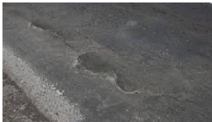
Gambar 2. 7 Kerusakan Jalan Mengembang ( upheaval ) Sumber : (Ziantono, 2016)
