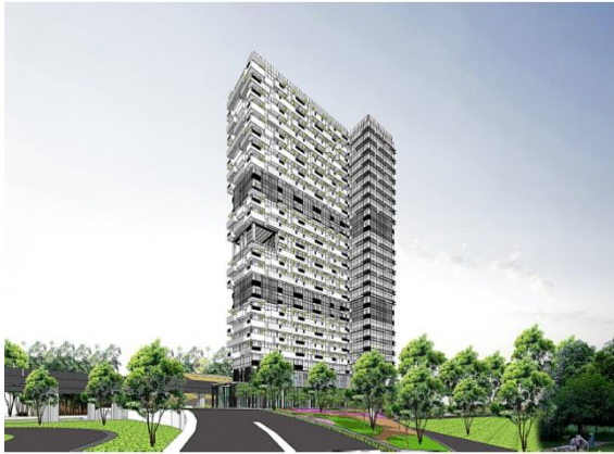
Gambar 1.1 Tampak Kanan Gedung Apartemen The Conexio LRT Superblock Sumber: (Adhi Persada Property)
