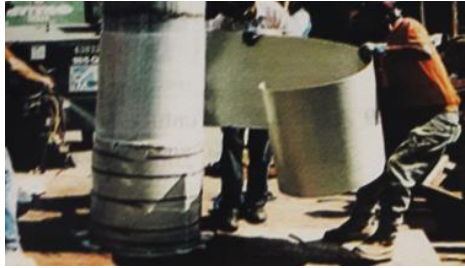
Gambar 2.5 Pengerjaan FRP dengan Metode Prefabricated Elements Sumber: (Makhdum, F. 2012)
