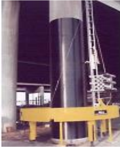
Gambar 2.6 Alat Otomatis untuk Jacketing FRP Sumber: (Oltean, R., dkk., 2009)
