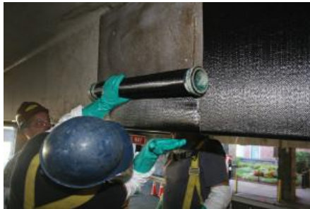
Gambar 2.4 Pengerjaan FRP Jacketing dengan cara Wet Lay-Up System
