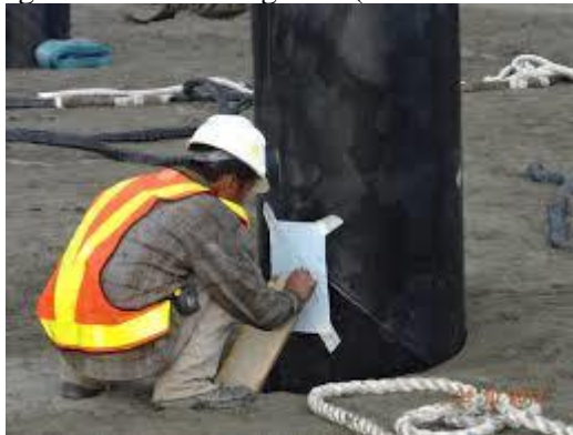
Gambar 8. 18 Contoh Proses Pencatatan Data Calendering (Sumber: kitasipil.com)
