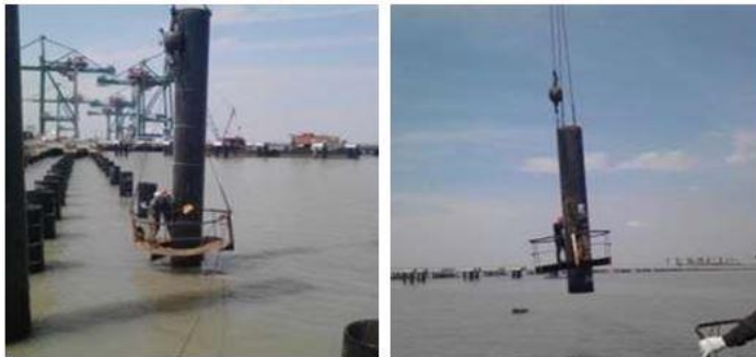
Gambar 8. 20 Contoh Proses Pemotongan Tiang Pancang
