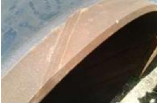
Gambar 8. 4 Bevel Pada Ujung Tiang Pancang Yang disambung
