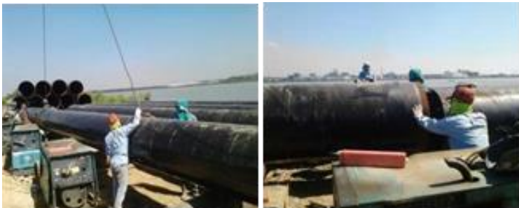
Gambar 8. 9 Proses Penggabungan Tiang Pancang
