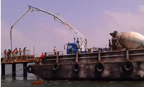
Gambar 8. 26 Pekerjaan Pengecoran di Laut
