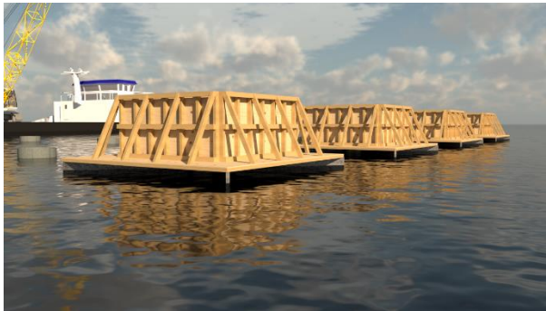
Gambar 8. 24 Ilustrasi Pemasangan Bekisting dan Perancah Pile Cap
