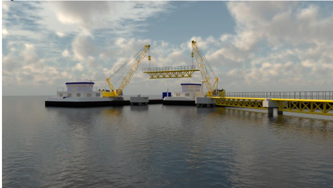
Gambar 8. 47 Pemasangan Catwalk
