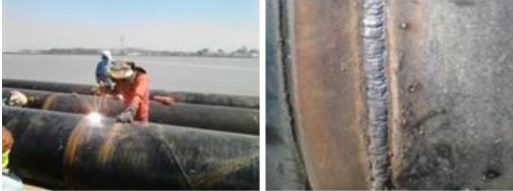
Gambar 8. 10 Proses Pengelasan Tiang Pancang di Darat
