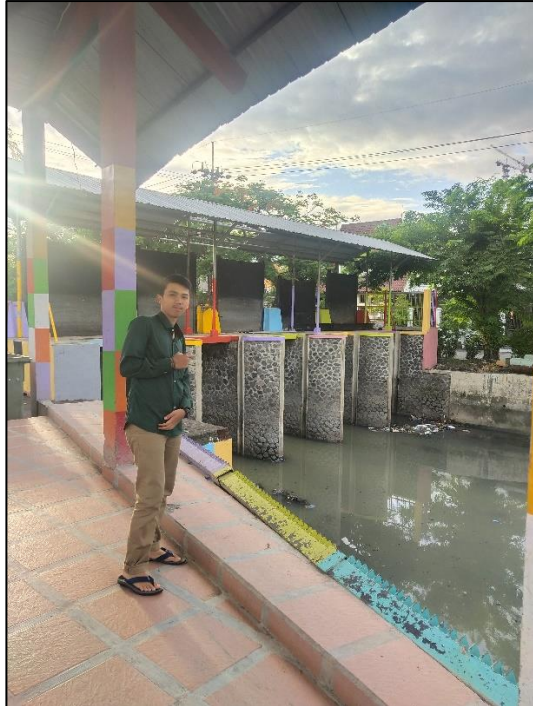
Gambar 1-1 Foto Pintu Air
