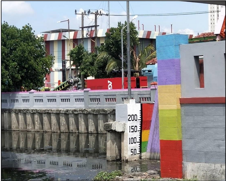
Gambar 2-1 Foto Boezem Kalidami Bagian Rumah Pompa I
