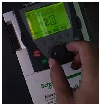
Gambar 4. 12 Penginputan Nilai Frekuensi pada VSDCGambar
