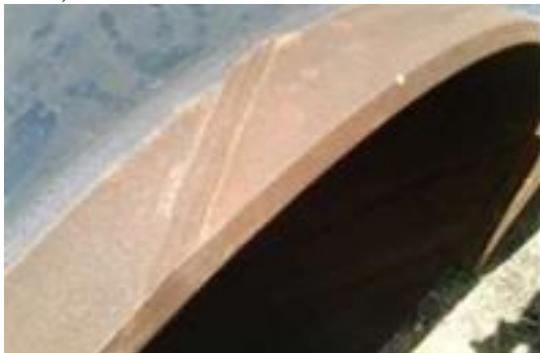
Gambar 7.6 Bevel Pada Ujung Tiang Pancang Yang disambung
