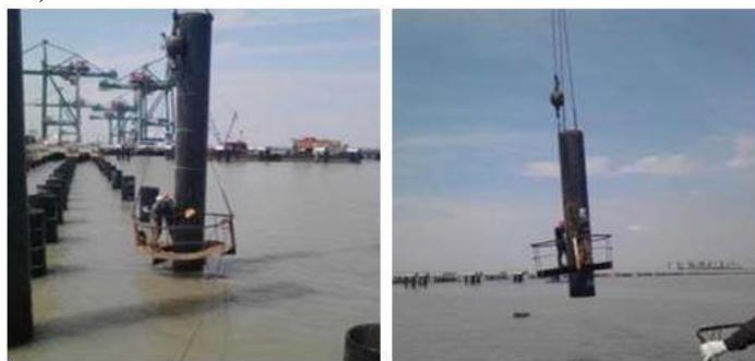
Gambar 7.28 Contoh Proses Pemotongan Tiang Pancang
