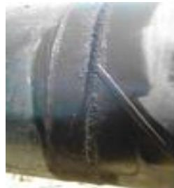
Gambar 7.16 Pelapisan Bahan Anti Karat Pada Permukaan Las
