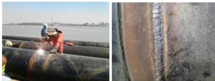
Gambar 7.15 Proses Pengelasan Tiang Pancang di Darat
