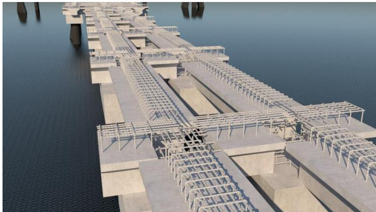
Gambar 7.43 Ilustrasi Pemasangan Balok Precast
