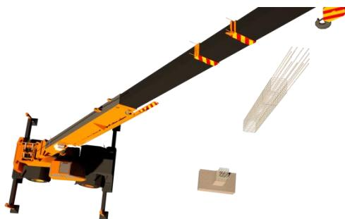
**Gambar 4. 120** Proses pemindahan tulangan kolom dari fabrikasi ke lokasi kolom
