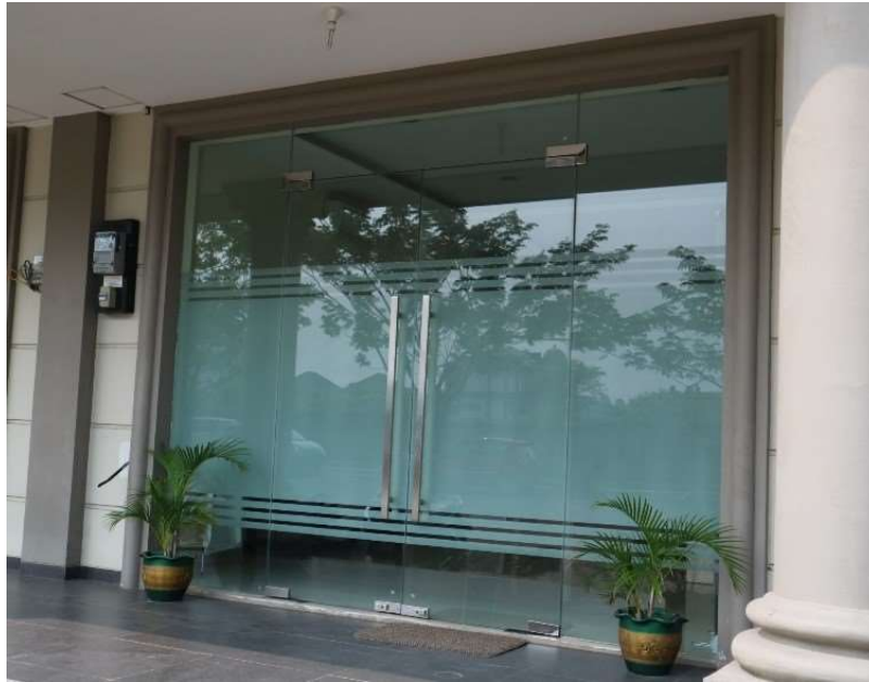
Gambar 2.11 Kaca Tempered Pada Pintu Kantor Sumber : https://www.arsigriya.com/
