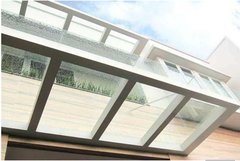
Gambar 2.12 Kaca Laminasi Pada Penutup Atap
