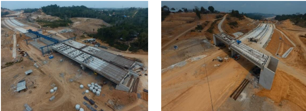
Gambar 2.2 Proyek Pembangunan Jalan Tol Balikpapan Samarinda
