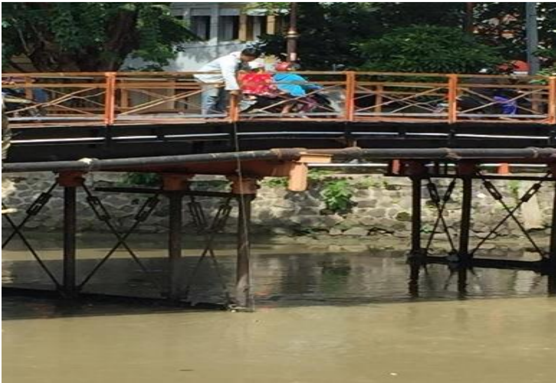
Gambar IV.5 Hasil Pengukuran Jembatan di Jl. Ahmad Jais
