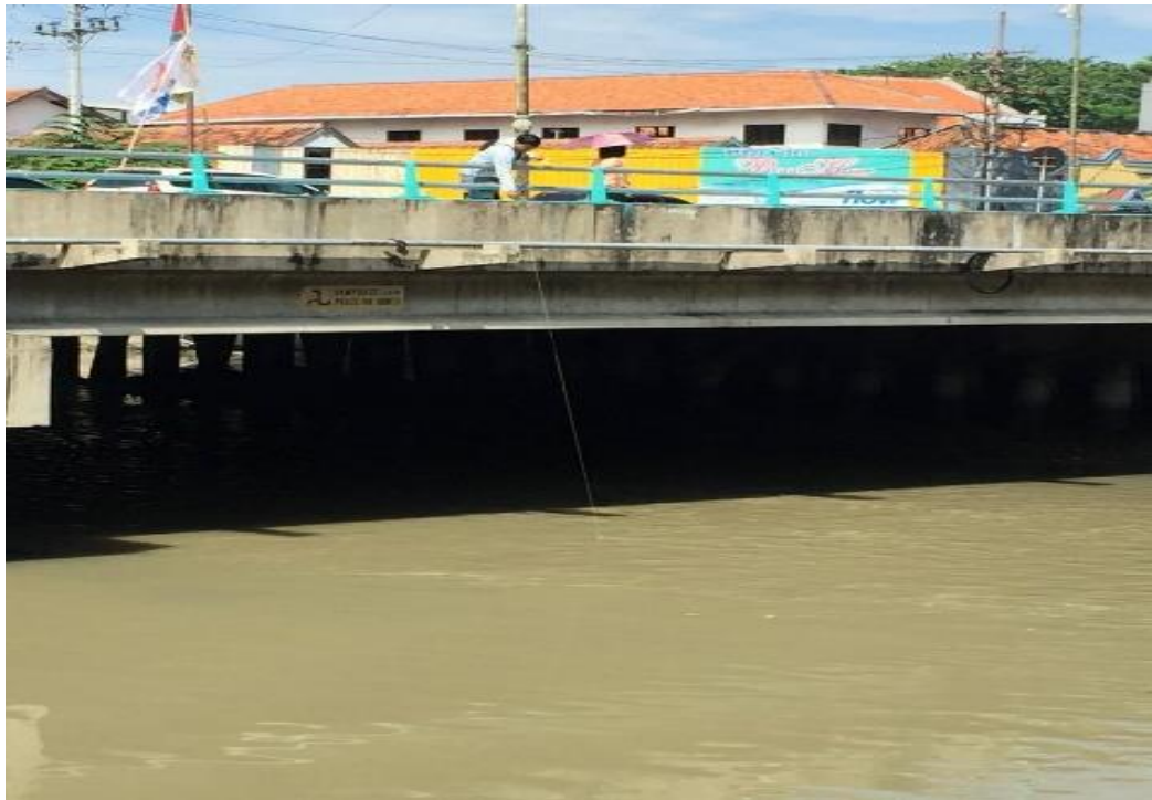
Gambar IV.6 Hasil Pengukuran Jembatan di Pasar Besar
