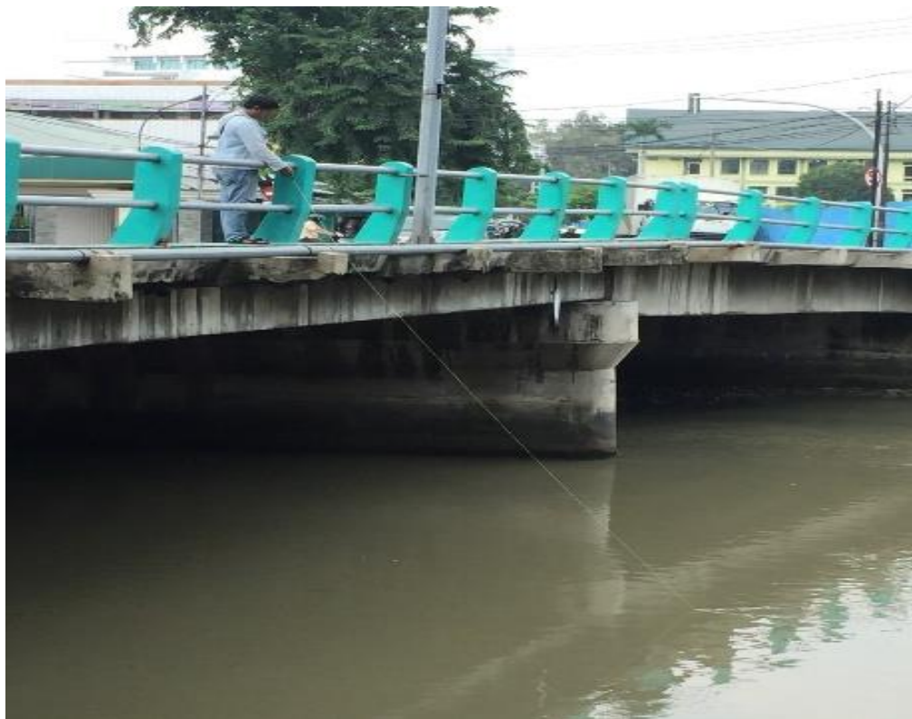
Gambar IV.7 Hasil Pengukuran di Jembatan Jl. Semut Kali
