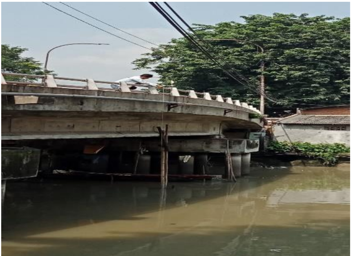
Gambar IV.10 Hasil Pengukuran di Jembatan Petekan
