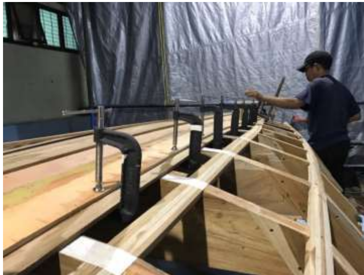
Gambar 4.42 Proses Pemasangan Kulit
