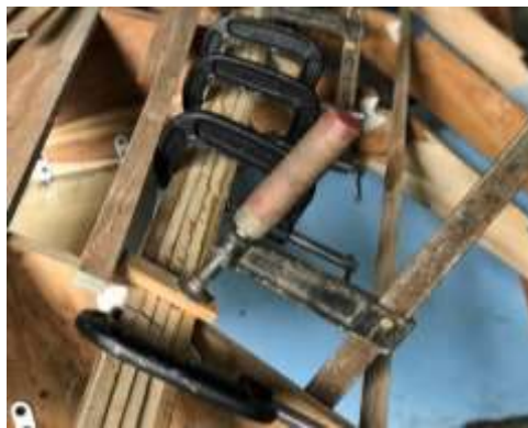
Gambar 4.38 Pemasangan Chine Lock
