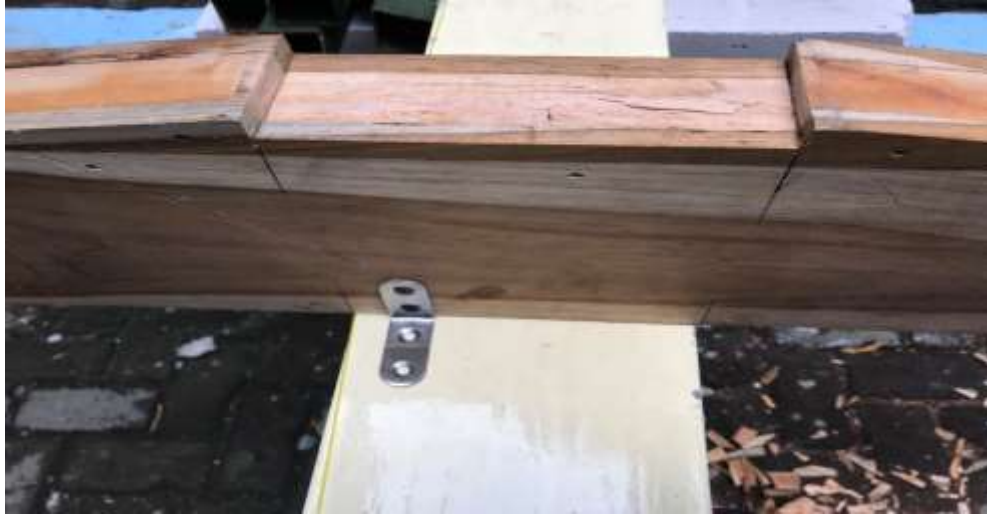
Gambar 4.22 Pembuatan Lajur Keel
