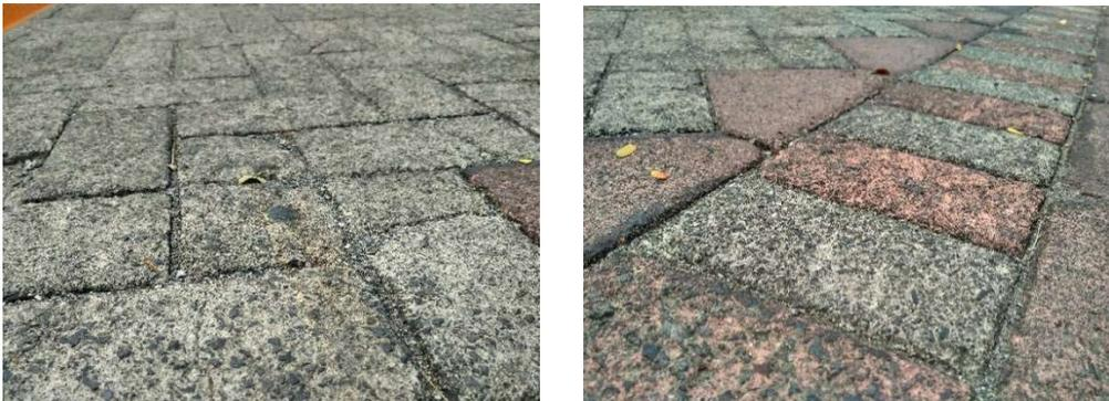
Gambar 3.17 Profil Jalan Paving Tidak Rata
