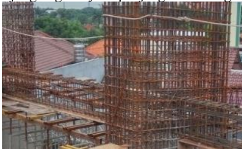
Gambar 4. 10 Pekerjaan Pembesian Balok
