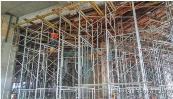
Gambar 4. 12 Pekerjaan Pembongkaran Bekisting Balok
