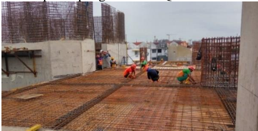
Gambar 4. 15 Pekerjaan Pembesian Plat Lantai
