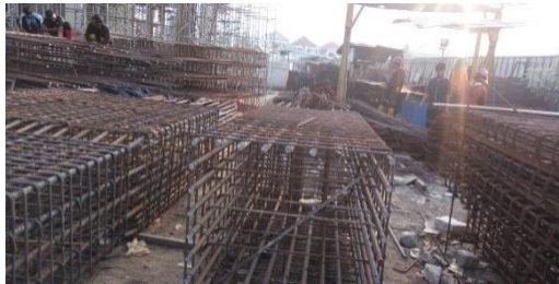
Gambar 4. 4 Pekerjaan Perakitan Kolom Sumber: Hasil Olahan Pribadi (2019)
