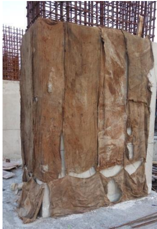
Gambar 4. 7 Setelah Pelepasan Bekisting Sumber: Hasil Olahan Pribadi (2019)
