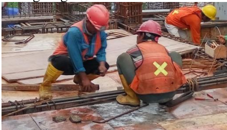
Gambar 4. 9 Pekerjaan Pemasangan Bekisting Balok
