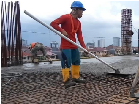
Gambar 4. 11 Pekerjaan Pengecoran Balok Sumber: Hasil Olahan Pribadi (2019)
