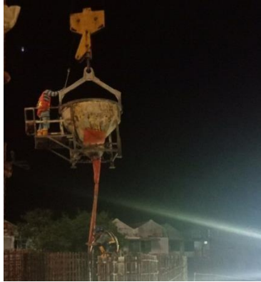
Gambar 4. 6 Pekerjaan Pengecoran Kolom Sumber: Hasil Olahan Pribadi (2019)
