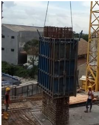
Gambar 4. 5 Pekerjaan Pemasangan Bekisting Kolom Sumber: Hasil Olahan Pribadi
