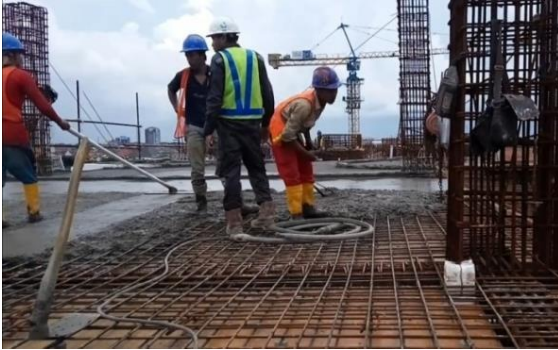
Gambar 4. 16 Pekerjaan Pengecoran Plat Lantai Sumber: Hasil Olahan Pribadi (2019)
