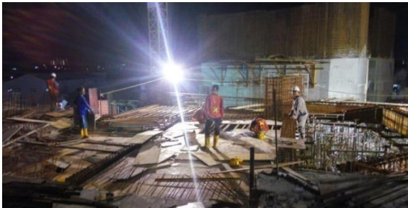
Gambar 4. 14 Pekerjaan Pemasangan Bekisting Plat Lantai Sumber: Hasil Olahan Pribadi (2019)
