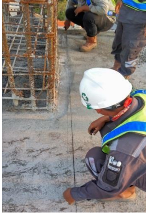
Gambar 4. 3 Pekerjaan Marking Kolom Sumber: Hasil olahan pribadi (2019)
