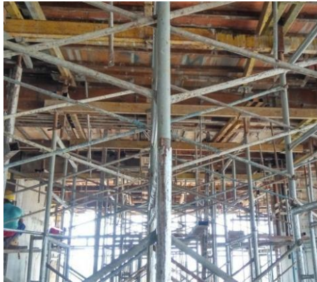
Gambar 4. 17 Pekerjaan Pembongkaran Bekisting Plat Lantai Sumber: Hasil Olahan Pribadi (2019)
