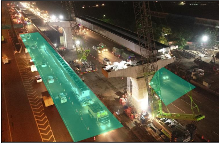
Gambar 3. 2 Proyek Konstruksi Tol Jakarta Cikampek II Elevated
