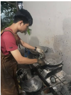
Gambar 1.d. Memanaskan agregat sebelum dicampurkan ke aspal (Tahap 4)
