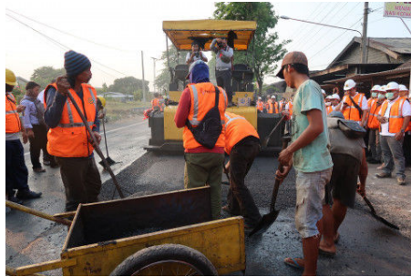
Gambar 1.I.2. Uji Gelar Teknologi Aspal Plastik di Pasuruan. (Pusjatan, 2016)
