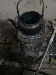
Gambar 1.a. Memanaskan aspal agar encer (Tahap 1)
