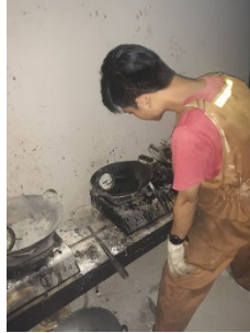
Gambar 1.c. Memanaskan aspal hingga suhu 155 °C sebelum dicampurkan dengan agregat (Tahap 3)
