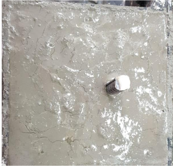
Gambar 15. Pemberian Tulangan Pada Beton Segar Sampel Galvanostatik
