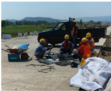
gambar 8. 6 pemberian tulangan dowel dan tie bar
