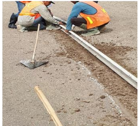
gambar 8. 1 pemasangan patok bekisting pada pekerjaan LC
