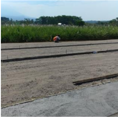
gambar 8. 1 pemasangan patok bekisting pada pekerjaan LC
