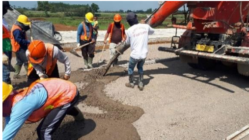
gambar 8. 3 pengecoran LC
