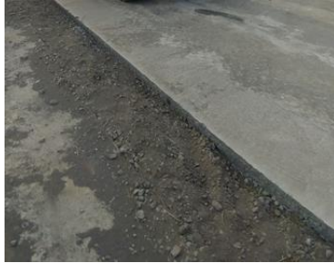
gambar 8. 4 LC setelah pelepasan bekisting
