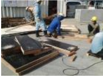
Gambar 7 26 Perakitan bekisting
