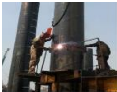
Gambar 7 17 Proses pengelasan tiang pancang.
