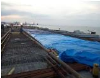
Gambar 7 33 Perlindungan beton dari suhu tinggi
