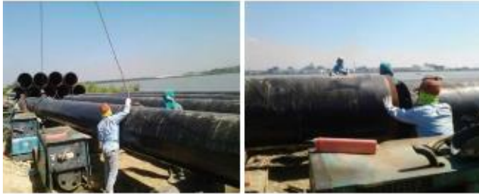
Gambar 7 11 Proses penggabungan tiang pancang
