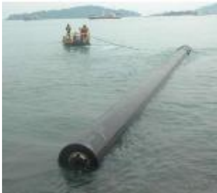
Gambar 7 14 Contoh mobilisasi tiang pancang ke titik pemancangan
