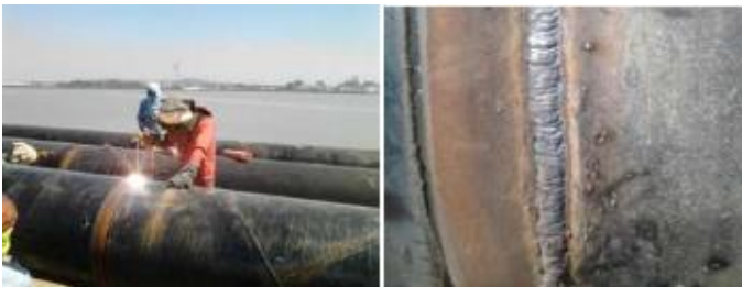
Gambar 7 12 Proses pengelasan tiang pancang di darat
