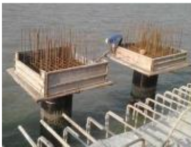
Gambar 7 27 Pemasangan bekisting pile cap
