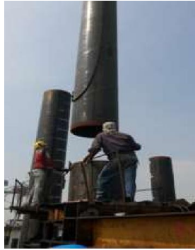
Gambar 7 16 Proses penyambungan tiang pancang di laut.
