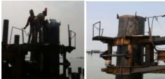
Gambar 7 15 Pemasangan stopper pada tiang pancang
