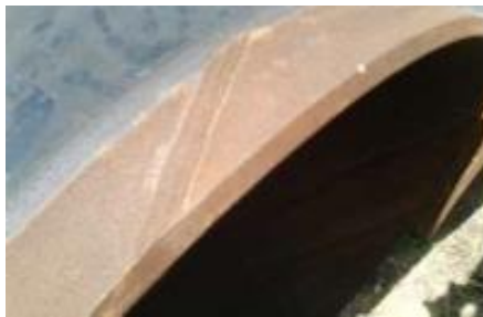
Gambar 7 10 Bevel pada ujung tiang pancang yang disambung
