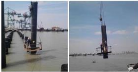
Gambar 7 23 Proses pemotongan tiang pancang
