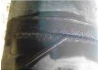
Gambar 7 13 Pelapisan bahan anti karat pada permukaan las.
