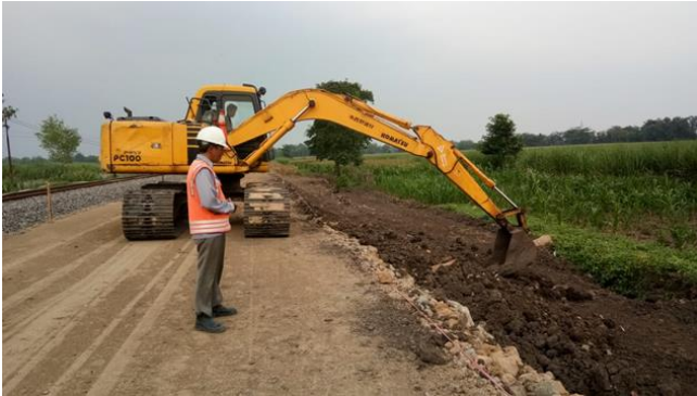
Gambar 1.6 Pemadatan Timbunan dengan Vibration Roller (Sumber : Gambar Proyek)
