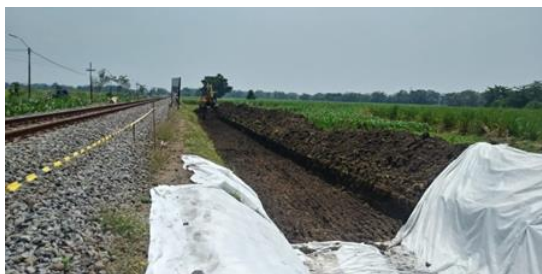
Gambar 1.5 Replacement (Sumber : Gambar Proyek)
