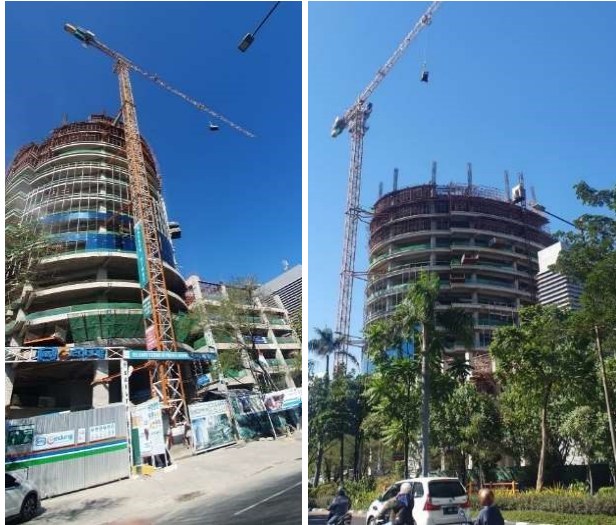
Gambar 4.2 Proyek Pembangunan Gedung Telkom Group Manyar
