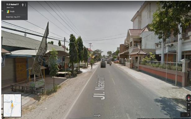
Gambar 1. 1 Kondisi Jalan Nasional Pantura Tuban – Gresik
