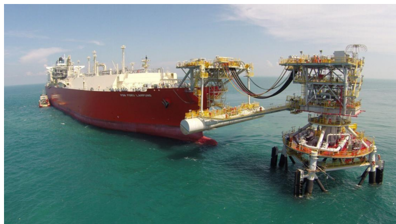
Gambar 5.10 Tower Yoke Mooring System pada FSRU
