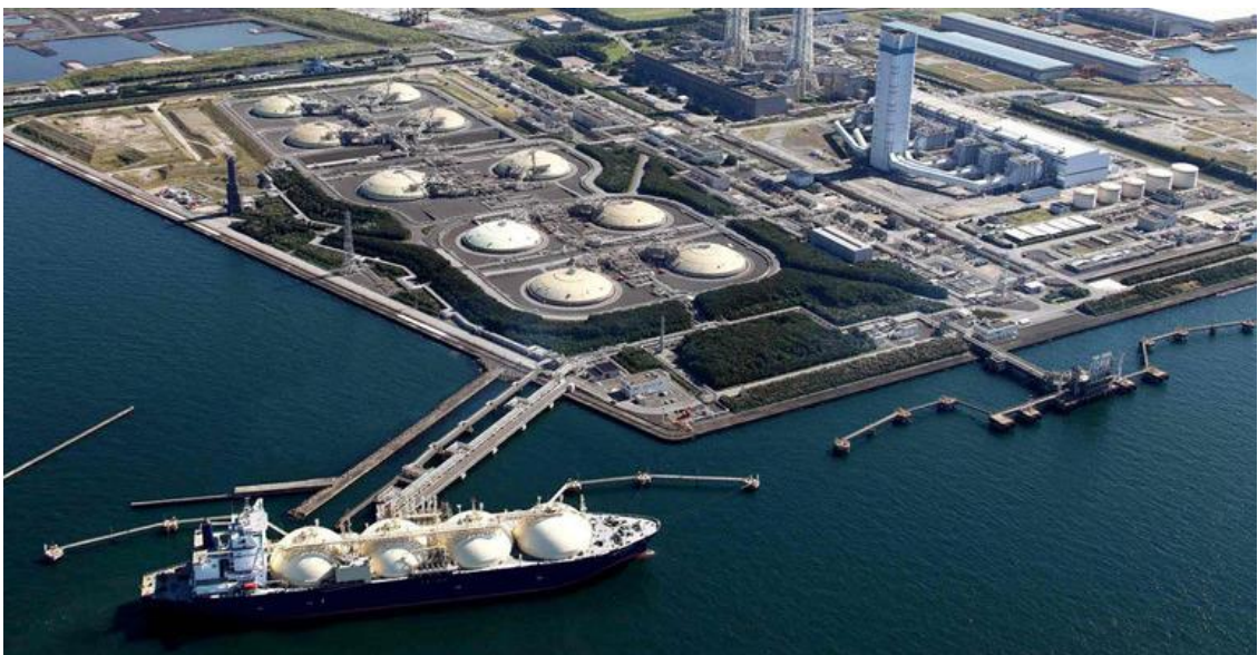
Gambar 5.5 Terminal LNG Futtsu ( TEPCO Power Station )
