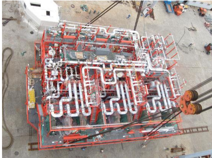
Gambar 5.15 Vaporizer IFV Propane pada FSRU Nusantara Regas Satu
