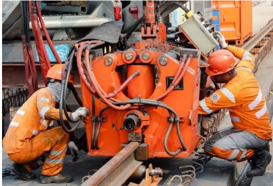
Gambar 2. 11 Pengelasan sambungan rel menggunakan metode Flash Butt Welding
