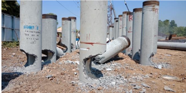
Sumber : Dokumen Pribadi Gambar 4. 2 Pekerjaan Pemotongan Tiang Pancang
