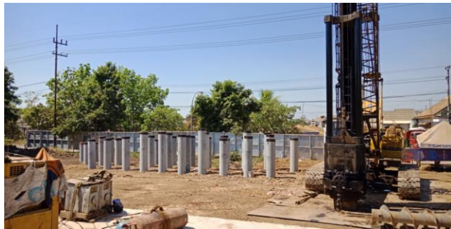
Sumber : Dokumen Pribadi Gambar 4. 1 Pekerjaan Pemancangan
