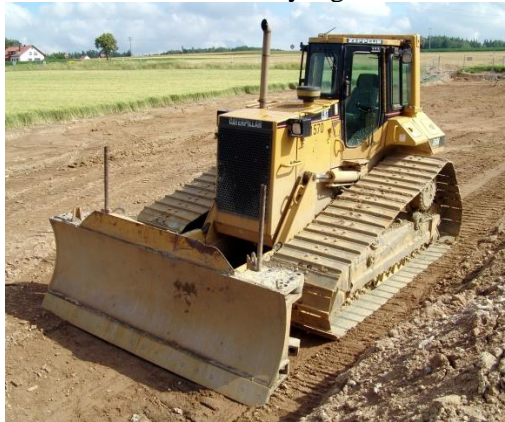
Sumber : Dokumentasi Penulis Gambar 2. 7 Bulldozer
