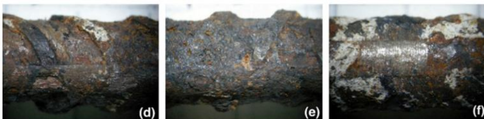
Gambar 2 - 4 Korosi tulangan baja pada beton yang direndam pada larutan klorida (Aguirre-Guerrero et al., 2016)
