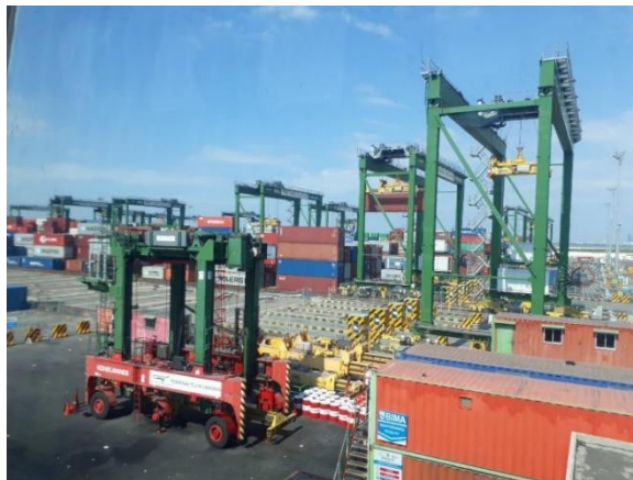
Gambar 4.8 Lapangan Penumpukan Terminal Teluk Lamong
