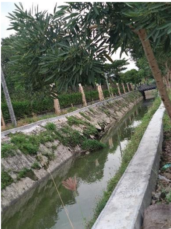
Gambar 2 Saluran Sungai Kendal pada Potongan 3 Sumber : Hasil Survey
