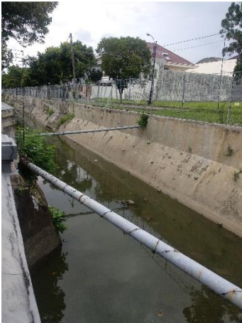
Gambar 1 Saluran Sungai Kendal pada Potongan 1 Sumber : Hasil Survey
