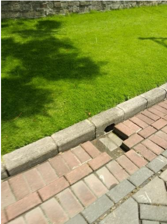
Gambar 5 Curb Inlet di Kawasan Perumahan Dian Istana Sumber : Hasil Survey
