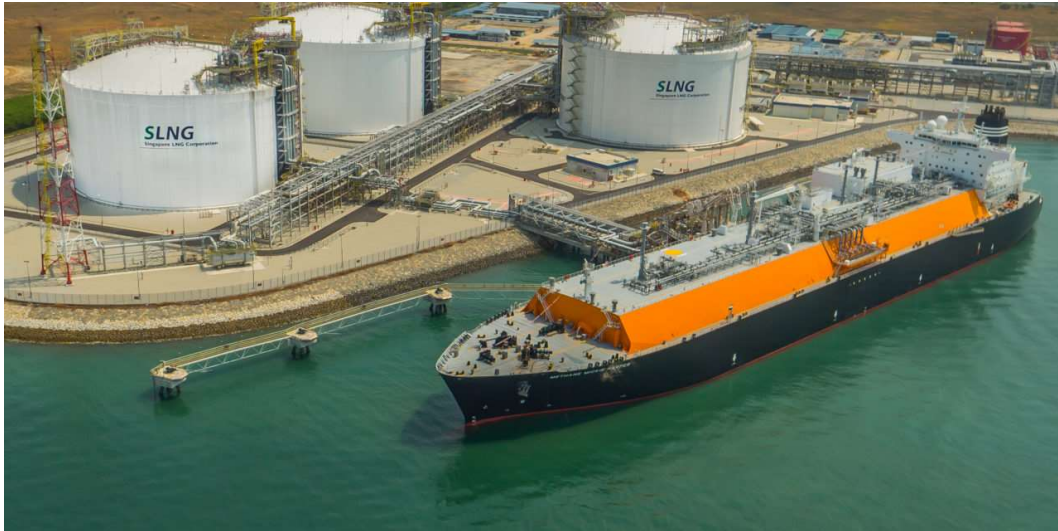
Gambar 2.5 Singapore LNG Terminal Sumber: Singapore LNG
