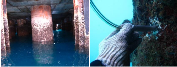
Gambar 4.25 Pengukuran Ketebalan Baja Pada Tiang Pancang
