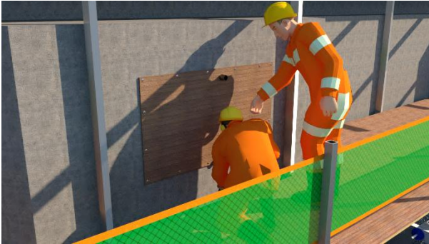
Gambar 8.35 Ilustrasi pengecekan formwork dan material
