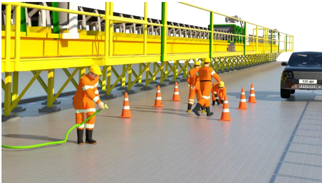
Gambar 8.13 Ilustrasi pembersihan permukaan beton
