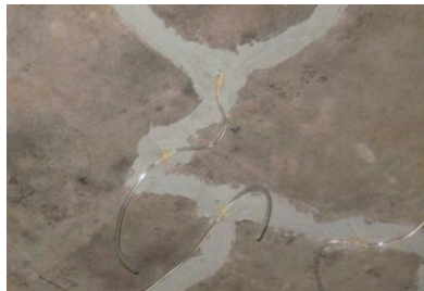
Gambar 8.8 Ilustrasi penyambungan antar kepala nipple
