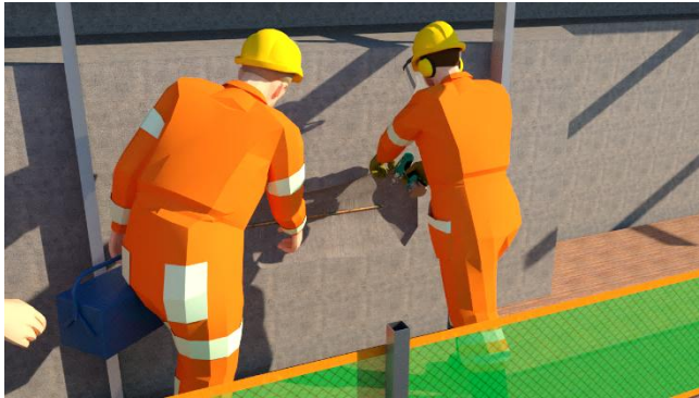
Gambar 8.29 Ilustrasi Pekerjaan Chipping Beton
