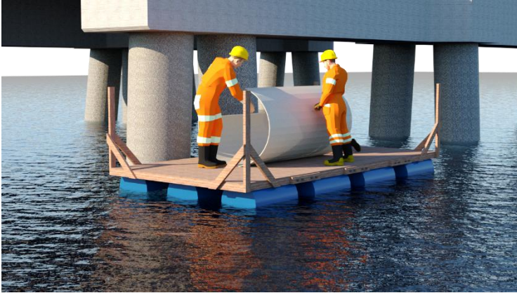
Gambar 8.44 Ilustrasi pengolesan seal gasket dengan epoxy pasta
