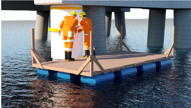
Gambar 8.46 Ilustrasi pemasangan temprrary bracing pada fiberglass jacket
