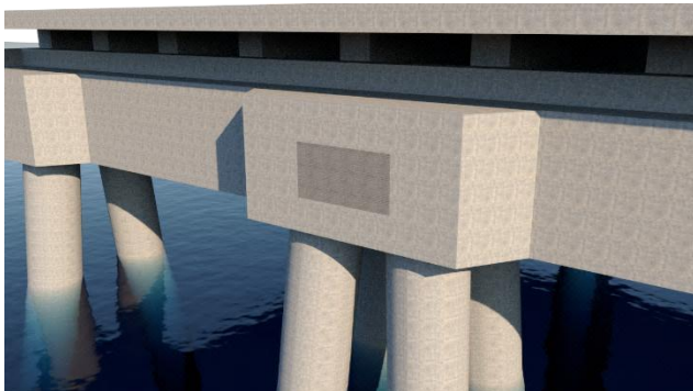
Gambar 8.38 Ilustrasi hasil akhir perbaikan grouting
