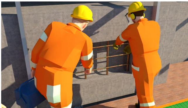
Gambar 8.30 Ilustrasi Pembersihan Baja Tulangan Terkorosi
