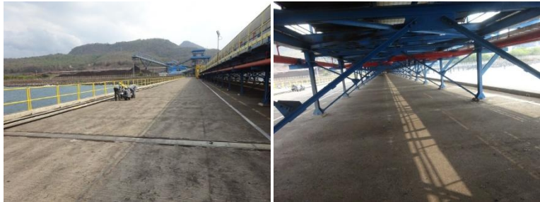
Gambar 4.2 Kondisi Plat lantai trestle dan conveyor
