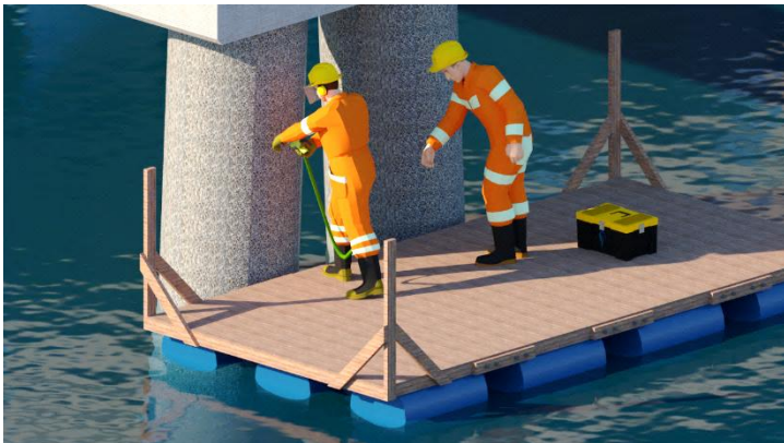
Gambar 8.43 Ilustrasi pembersihan permukaan tiang
