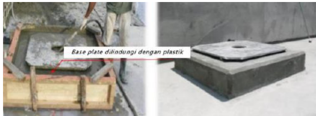
Gambar 10. 8 Pengecoran kolom pedestal bawah
