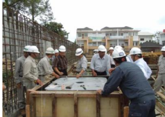
Gambar 10. 7 Pemasangan bekisting kolom pedestal bawah
