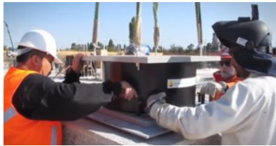
Gambar 10. 13 Pemasangan baut bawah
