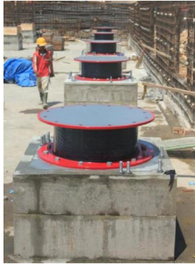
Gambar 2. 5 Pemasangan HDRB pada Hotel Ibis Padang (Suardi, 2013)
