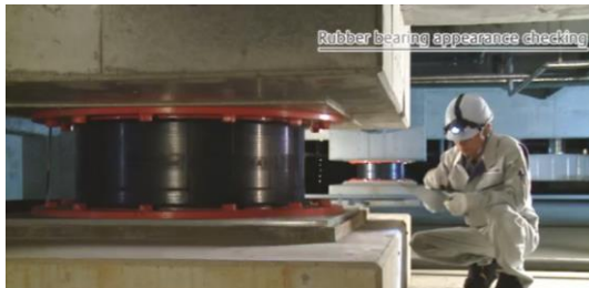
Gambar 10. 17 Inspeksi Pemeliharaan HDRB (Bridgestone, 2013)
