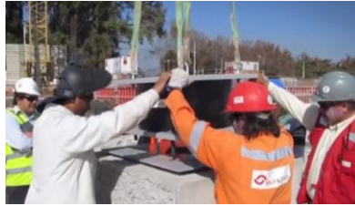
Gambar 10. 12 Pemasangan Rubber Bearing
