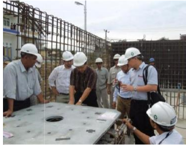
Gambar 10. 5 Pemasangan Base Plate
