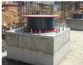
Gambar 10. 14 Pemasangan top plate
