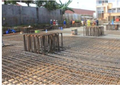
Gambar 10. 2 Tulangan Kolom Pedestal Bawah
