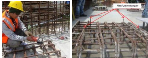
Gambar 10. 4 Pemotongan besi dudukan base plate
