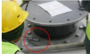
Gambar 10. 15 Pengencangan baut dengan kunci momen
